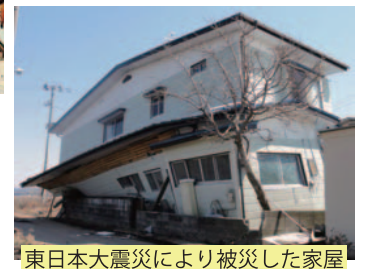
東日本大震災により被災した家屋
