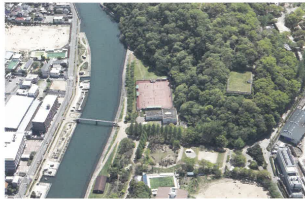
にしまる 西の丸配水場・城山配水池 徳島中央公園内にあり、調整池の上にはデ ニスコート3面が作られています。
