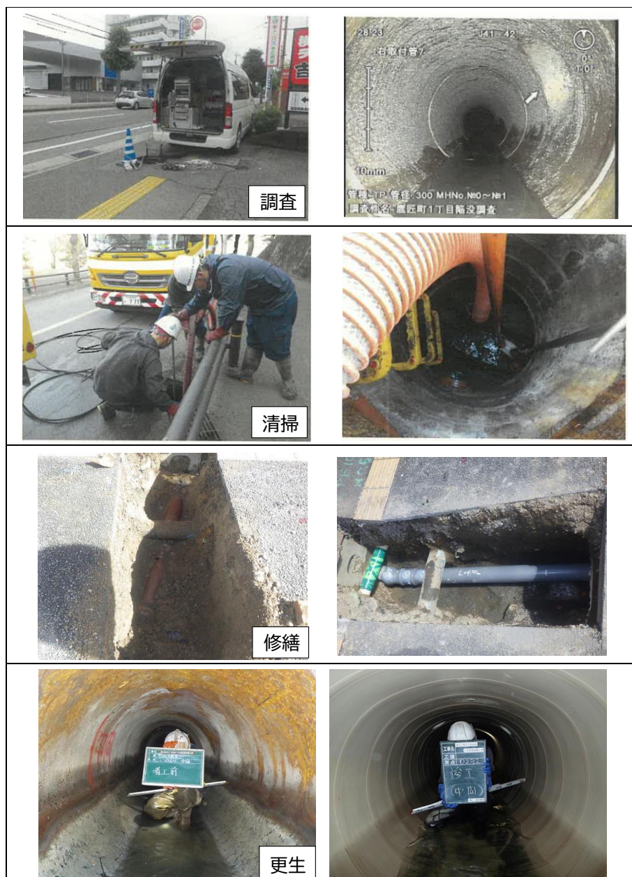
図 3-2 老朽管の調査・清掃・修繕・更生 (※33)
