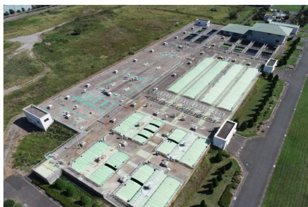
北部浄化センター
