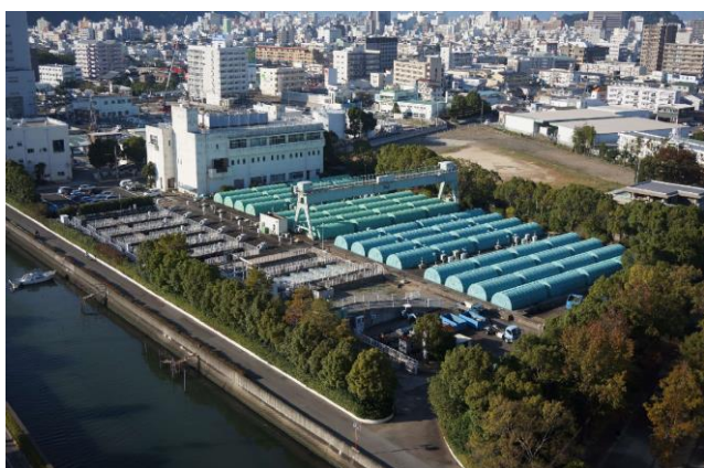
中央浄化センター
