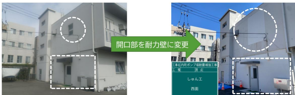
図 3-5 処理場・ポンプ場の耐震補強
