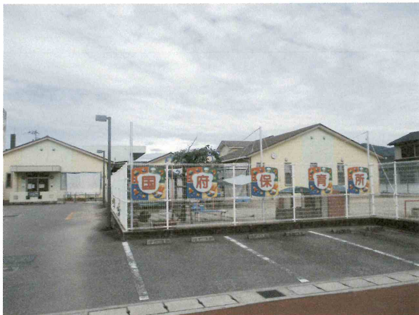
建物外観と駐車場
