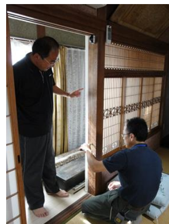
耐震診断の実施の様子
