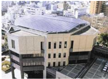
徳島市庁舎太陽光発電システム
