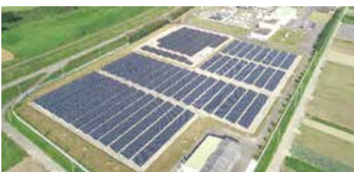
太陽光発電の設置 (第十浄水場) じょうすい
