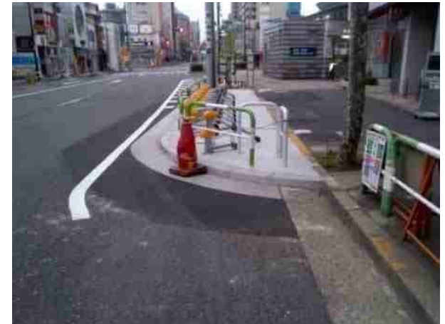
東京都豊島区新大塚駅周辺における 歩道を一部拡幅しての駐輪施設設置例
