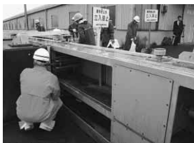
水害に備えて樋門を点検(津田海岸町)
