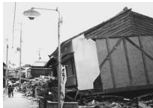
平成7年の阪神・淡路大震災で倒壊した木造住宅。この地震で死亡した人の約8割は、住宅の倒壊によるものと推定されている。
