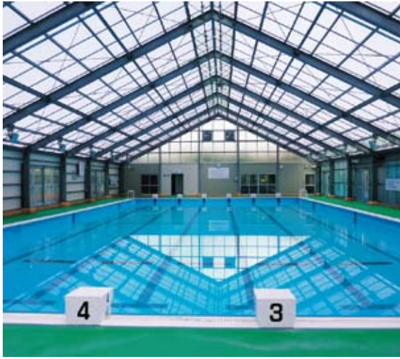
▲屋根が改修されたB&G海洋センタープール
