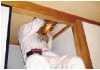
▲耐震診断の様子
