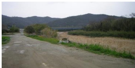
【園瀬川】川西地区の堤防整備の促進
