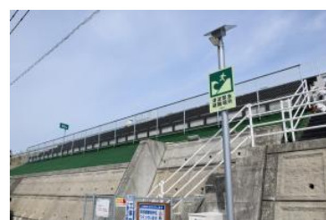
津波避難施設
