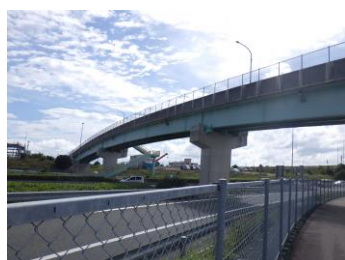
橋りょうの耐震補強
