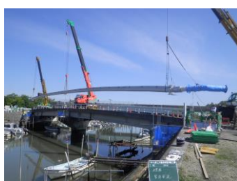
橋りょう添架管架替工事
