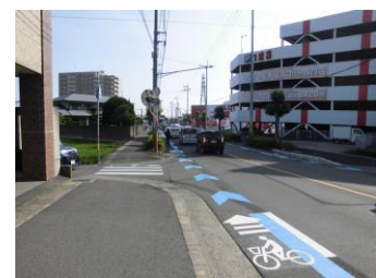
自転車走行空間整備
