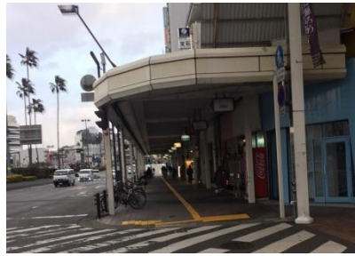
にぎわいが感じられる景観となっていない国道 438 号沿道
