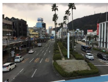
交通量に対して、余裕のある車線数を持つ新町橋通り
