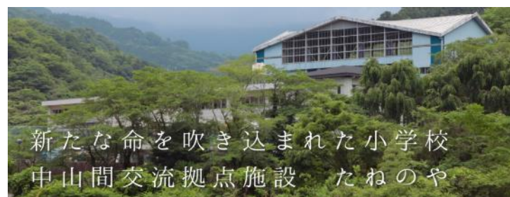
新たな命を吹き込まれた小学校 中山間交流拠点施設 たねのや
