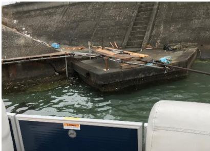
船着場設置候補箇所の現況調査
